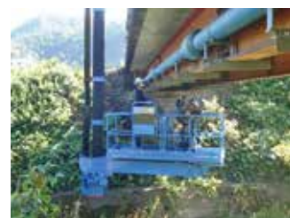
橋りょう点検
