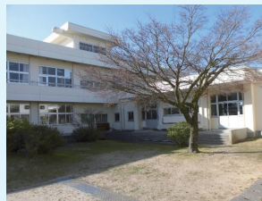
▲閉校施設 (旧分田小学校)
