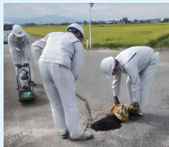
▲道路の損傷を補修
