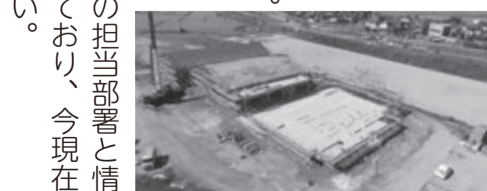
工事が進む道の駅
