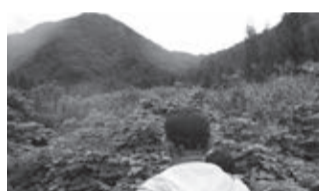
上山林道上流の盛土跡
