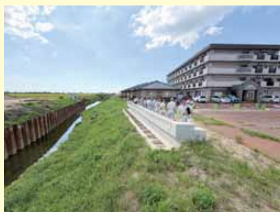
安野町地内(駒林川)
