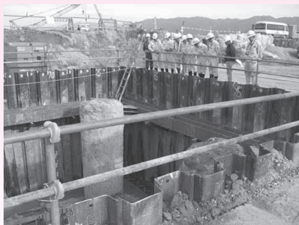
小里川2号橋下部工事現場のようす
