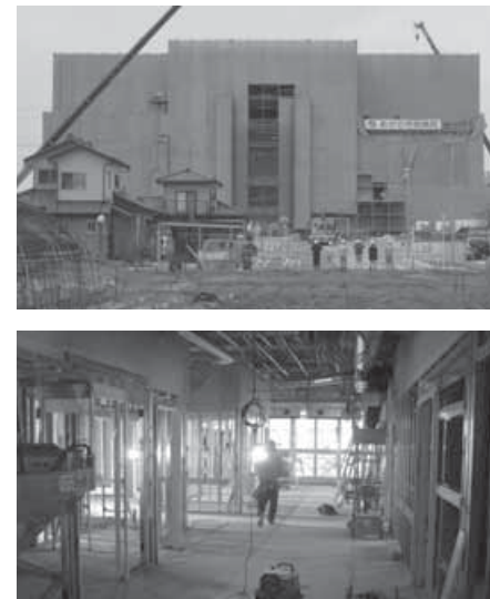
内装工事の様子（1階階段）
