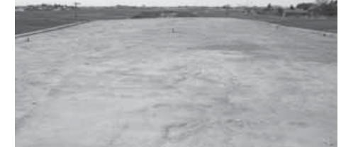
高盛土の上から新潟市方面を撮影(飯盛杉地内)
