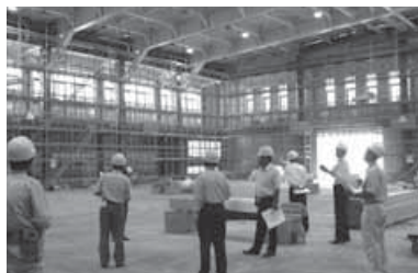
屋体棟内部の様子
