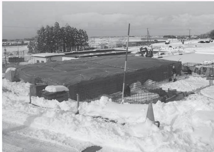
浄水発生土の保管施設を兼ねた天日乾燥床増設工事のようす
