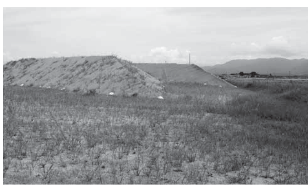
阿賀野バイパス黒瀬地内の法線内盛土
