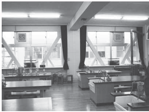
理科室(鉄筋の補強筋交い、照明器具取替)
