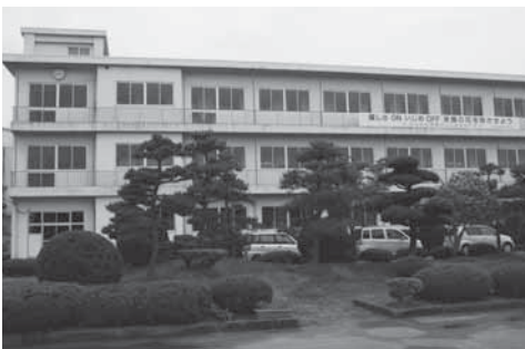
築50年経過の水原中学校
