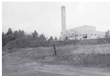
現在の最終処分場。写真中央にガス抜き管が見えるが、ガスの発生はほとんどないとのこと。
