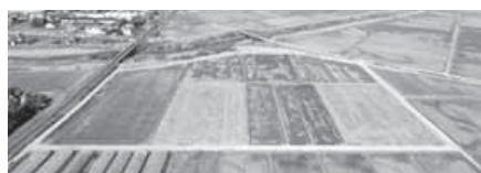
県営ほ場整備「中ノ通地区」 (第8工区) 面工事完了箇所
