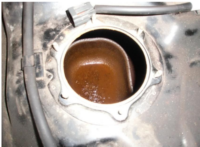
□燃料タンク内、錆状況
