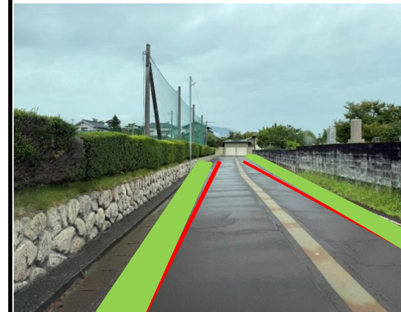
現場写真①
