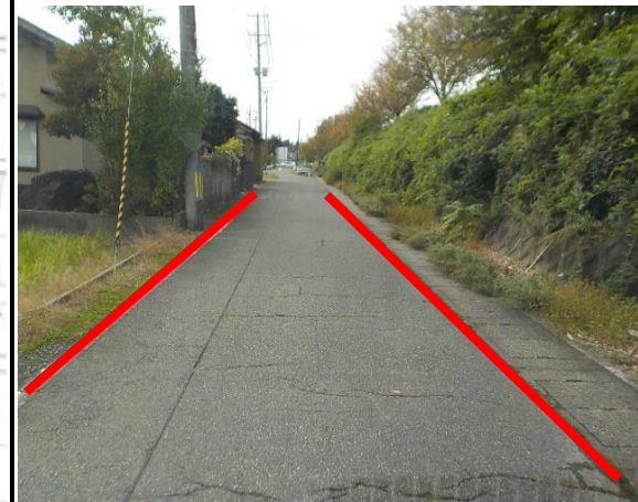
現場写真①
