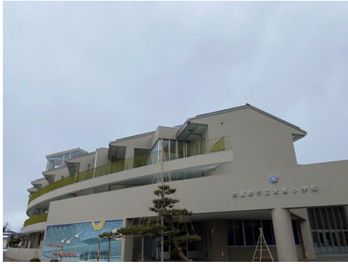
校舎外壁 (水原小学校大規模工事)
