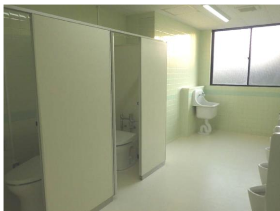
児童1階男子トイレ (京ヶ瀬小学校トイレ改修工事)
