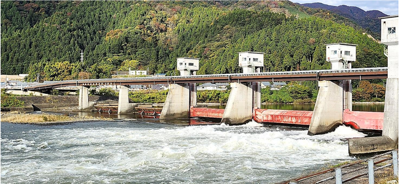
【阿賀野川頭首工】
