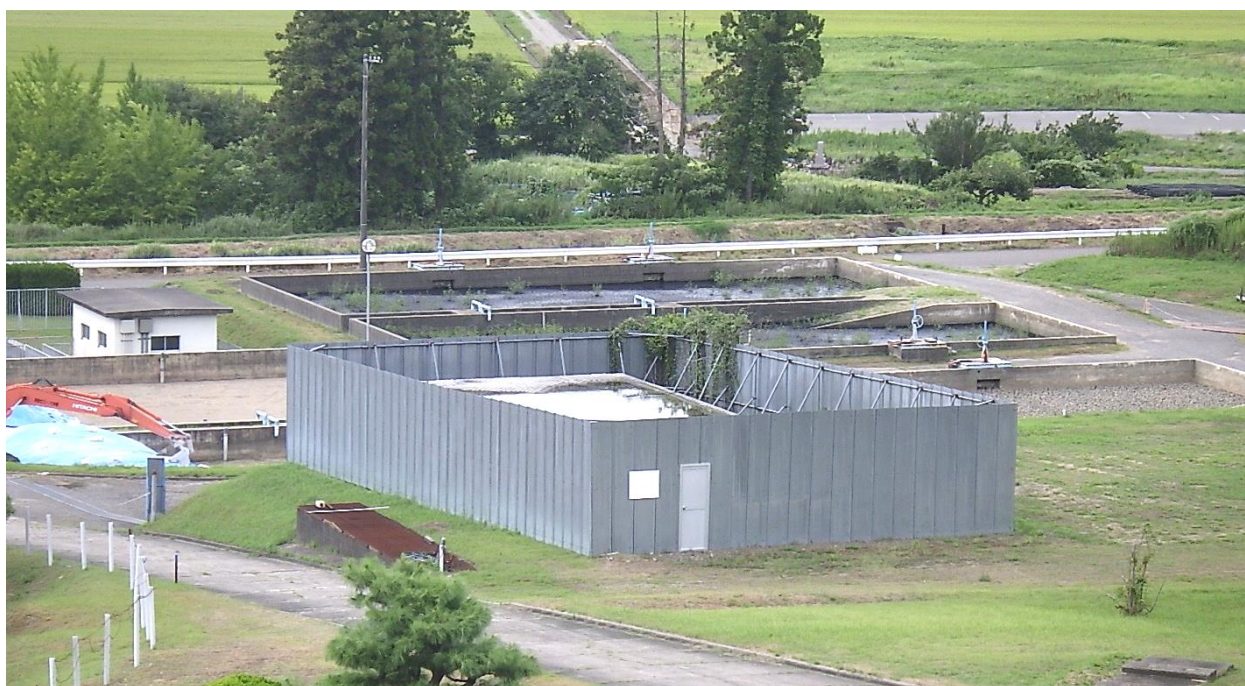
【大室浄水場における浄水発生土保管状況】
