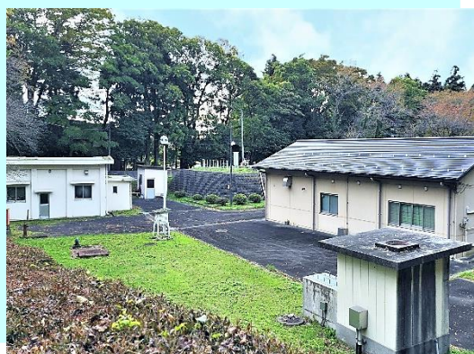
【渡場水源地取水場】
