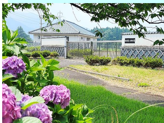
【渡場第二浄水場】
