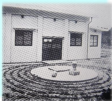
【昭和 37 年渡場水源地取水場】
