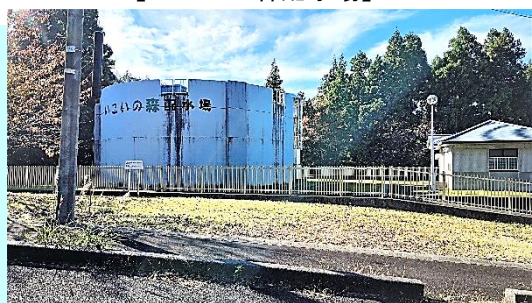
【いこいの森配水場】
