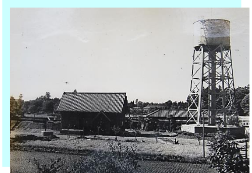
【昭和 30 年旧水原町給水タンク】
