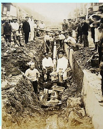
【昭和 11 年旧水原町本町通り鑄鉄管布設】
