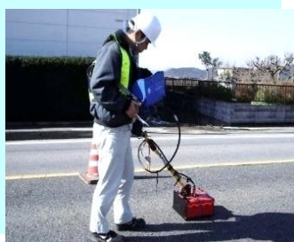
【地中レーダーによる漏水調査】
