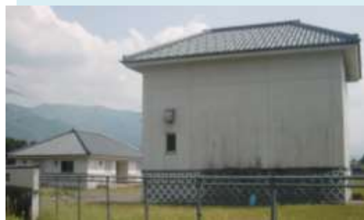
【渡場第二浄水場】
