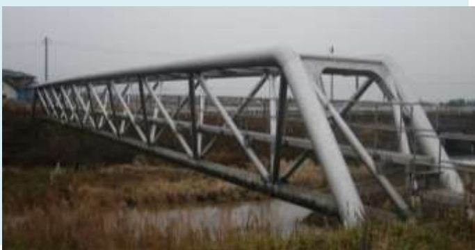
【国道 460 号 折居川φ350 SUS 水管橋】
