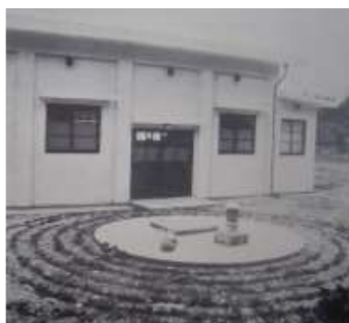
【昭和 37 年渡場水源地取水場】
