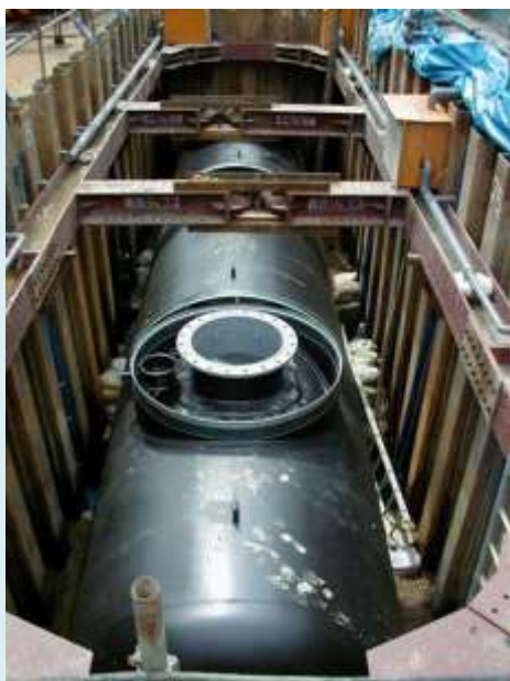
【飲料水兼用耐震性貯水槽（60 m³）】
