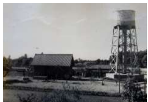
【昭和 30 年旧水原町給水タンク】
