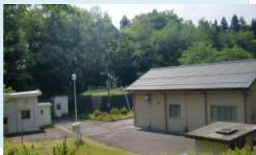
【渡場水源地取水場】
