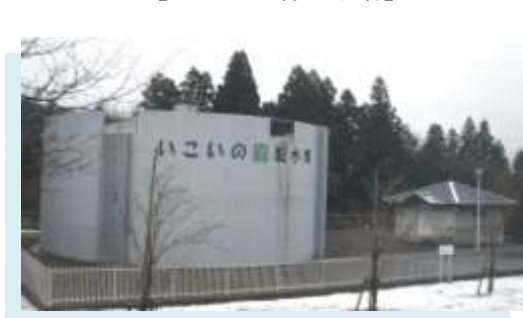
【いこいの森配水場】
