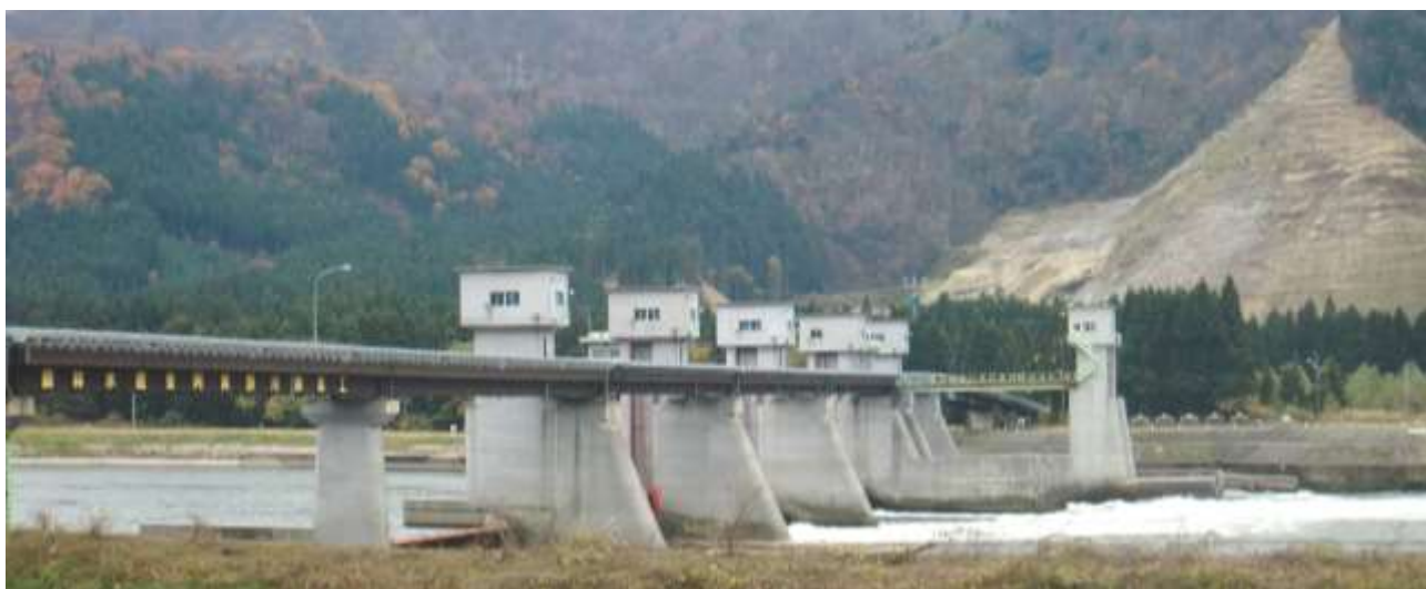
【阿賀野川頭首工】
