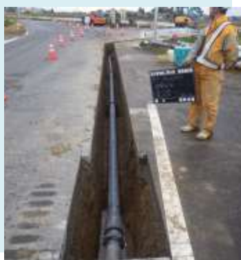
【GX-S 形鋳鉄管 φ150 mm 布設状況】
