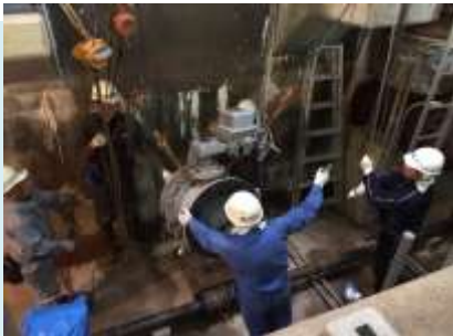
【ろ過池逆洗弁φ500 取替状況】
