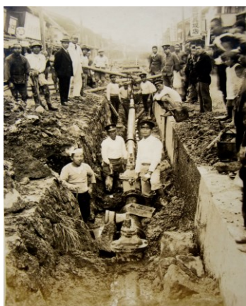
【昭和 11 年旧水原町本町通り鑄鉄管布設】
