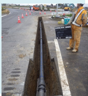
【GX-S 形鋳鉄管 φ150 mm 布設状況】
