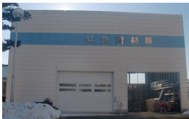
【上下水道局緊急資材庫】
