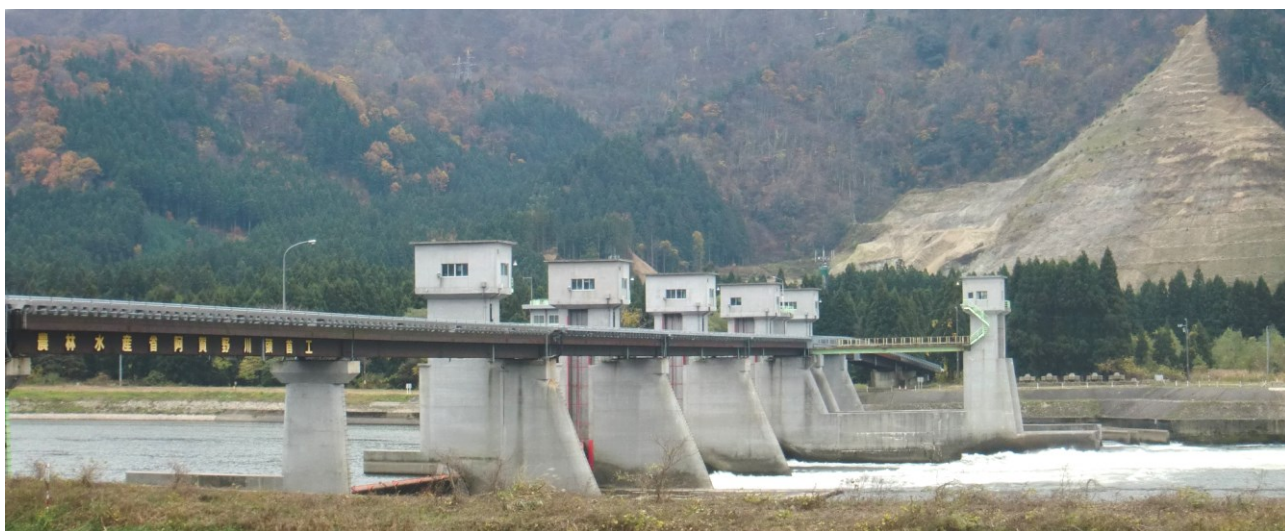
【阿賀野川頭首工】
