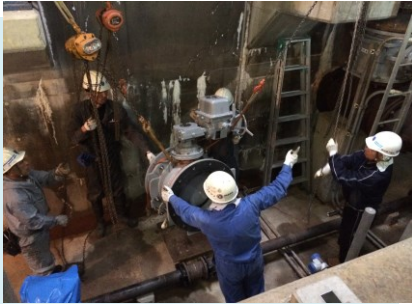
【ろ過池逆洗弁φ500 取替状況】
