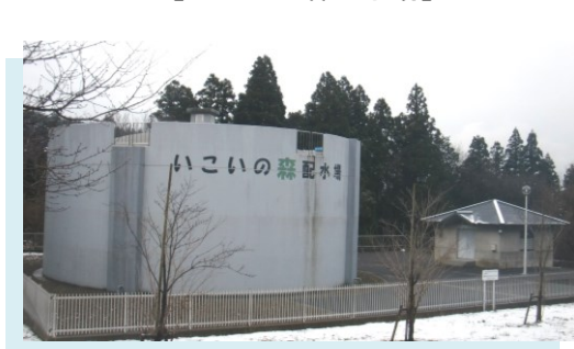
【いこいの森配水場】
