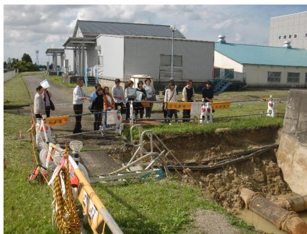
沈砂池工事現場見学
