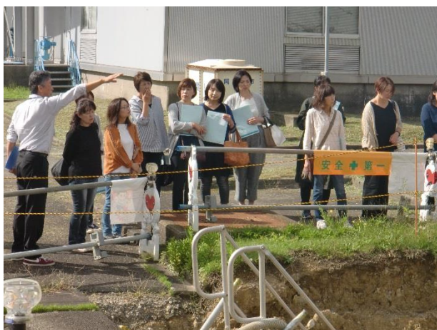
沈砂池工事現場見学
