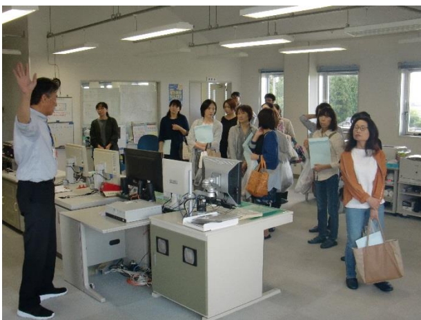
中央監視室見学
