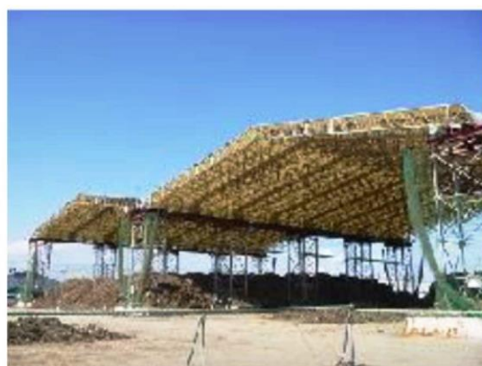
可燃物の貯留ヤード 宮城県石巻市 平成25年6月
