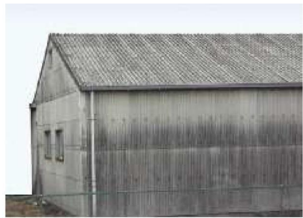
石綿含有スレート波板（屋根・外壁）
