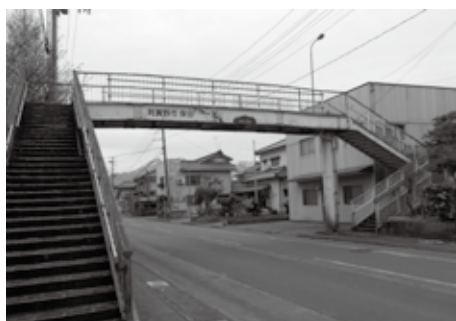
撤去前の歩道橋
