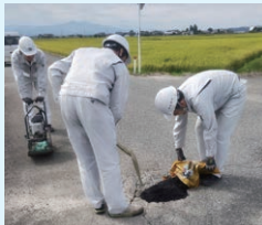
▲道路の損傷を補修補助
