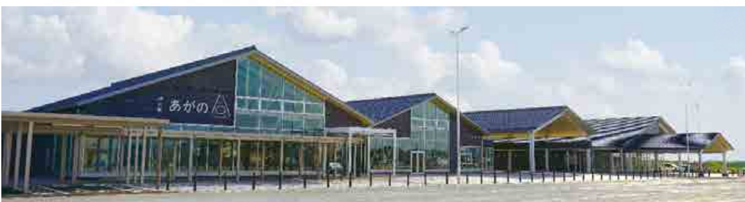
▲令和4年8月オープン 道の駅「あがの」
