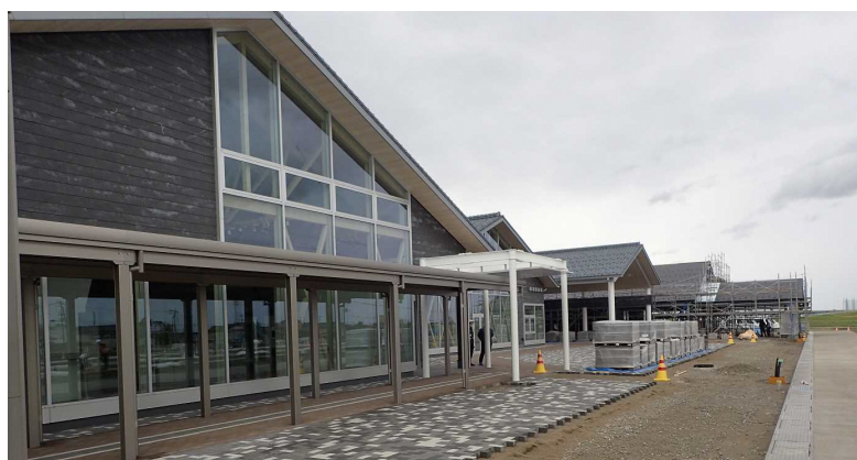
道の駅「あがの」の工事状況(R4. 6. 6撮影)
