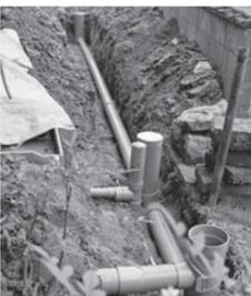
汚水ますを排水管に接続します。排水管は、宅内からの全ての排水が合流する公共ますに向かって約2%の勾配がとられています。この勾配が緩いと汚水の停滞を招き、逆に強すぎると汚水だけが流れ、固形物が残ってしまう場合があります。
