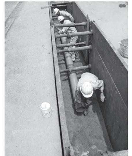
下水道は各家庭の汚水を自然の勾配を利用して下流に流すため、下水道管を埋設する高さや方向が重要となります。埋設する下水道管1本ごとに高さ・方向をしっかり測定・調整しながら埋設します。現場の状況によって変わりますが、1日に約4～8m（下水道管1、2本）のペースで埋設していきます。
