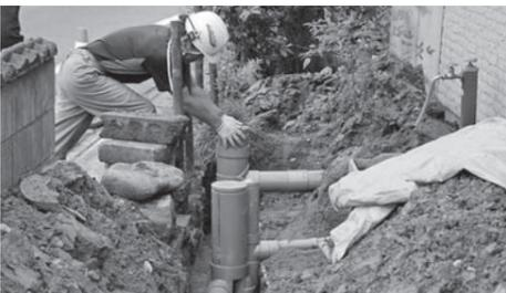
台所や風呂、トイレから出る排水管の先に汚水ますを設置します。汚水ますにはさまざまな種類があり、洗面台や洗濯機の排水管の先には、トラップますと呼ばれるものを設置し、臭気や虫の屋内侵入を防ぎます。汚水ますは排水管の点検口となり、詰まり等のトラブル復旧の際に使用します。
