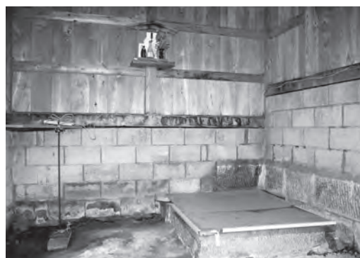
③ 村杉温泉街の一角にある薬師乃湯の1号井 ※普段は施錠されていて、中を見ることはできません。
