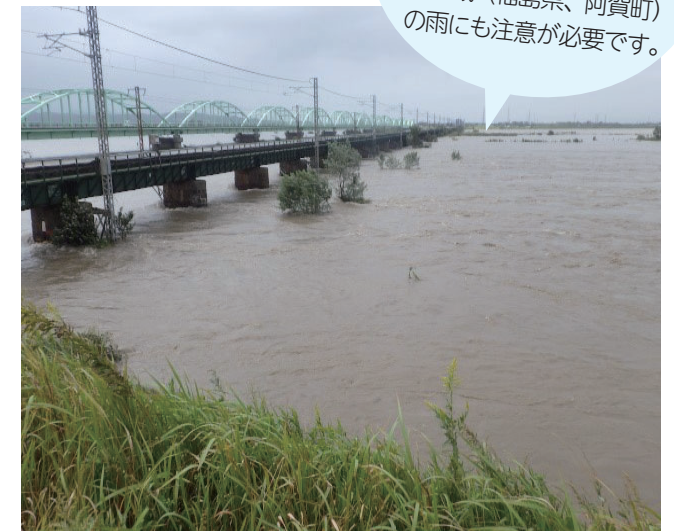
▲氾濫寸前の水位まで増水した阿賀浦橋（下里地区）
