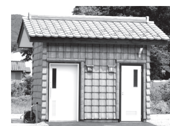
新設されたトイレと東屋
