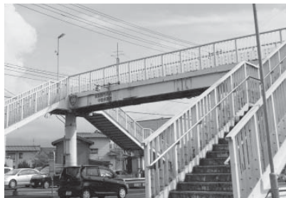
国道49号線歩道橋 (水原小学校前)
