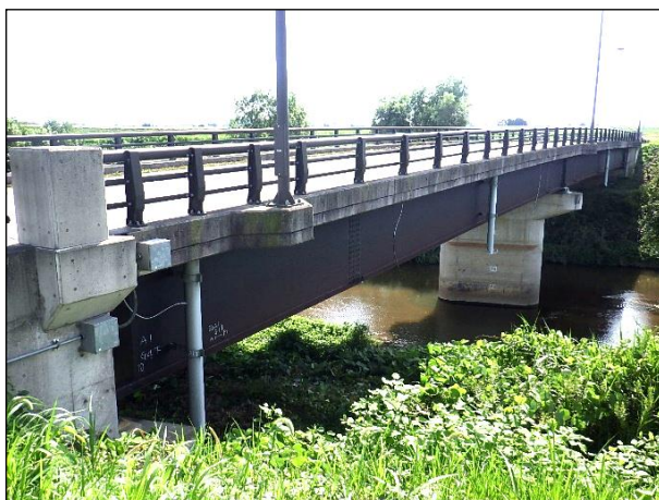
写真全景（鋼橋）
