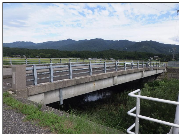
写真全景（コンクリート橋）
