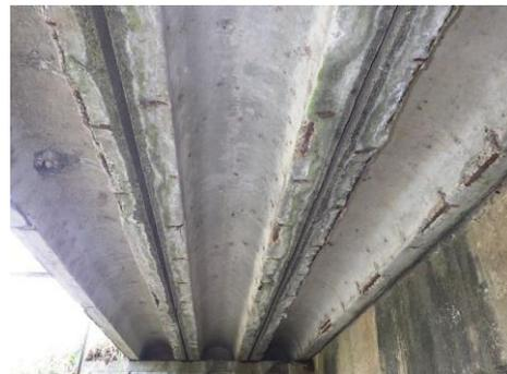
コンクリート橋の剥離・鉄筋露出等
