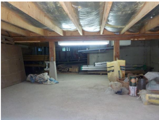
床下収納（地下室）
