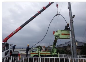
■水原総合体育館大規模改修
