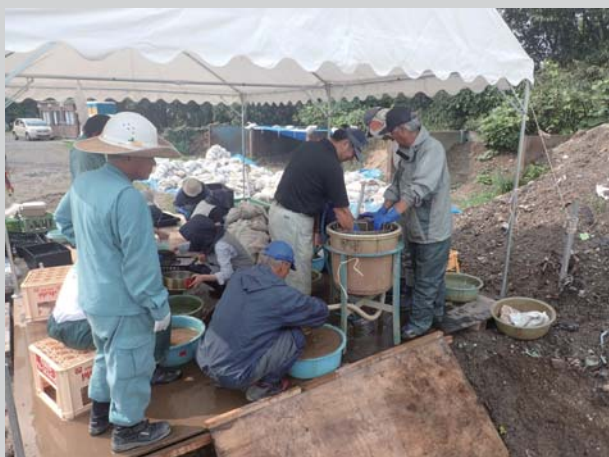
写真5：土壌洗浄作業の様子
