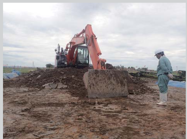
第 3 図 表土掘削の様子
