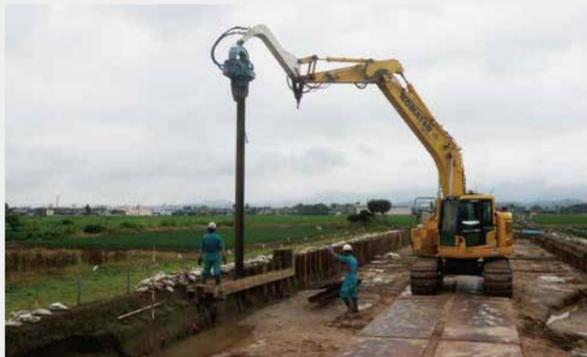
写真11 鋼矢板打設状況
