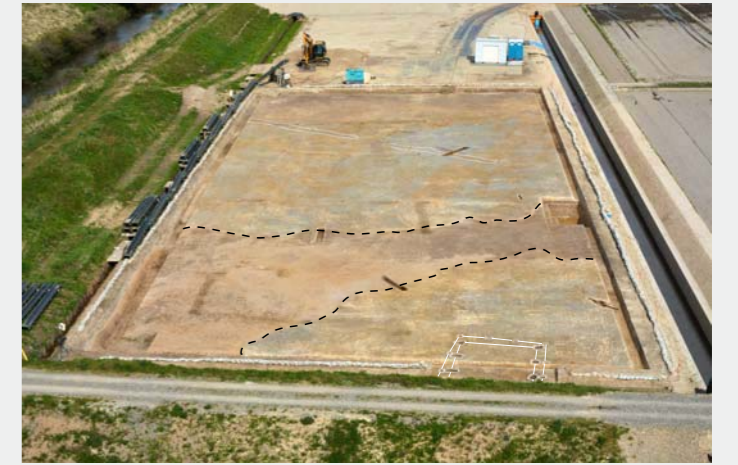
C区（本年度調査）全景（西から）
