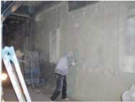
断熱工事(発泡ウレタン吹付けの様子)
