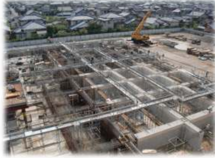
8月の猛暑の中で、暑さに耐えながらの作業が続く。（基礎工事）
