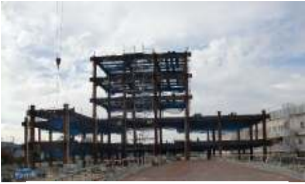
鉄骨建て方の様子（10月24日撮影）
