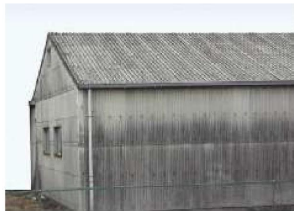
石綿含有スレート波板（屋根・外壁）
