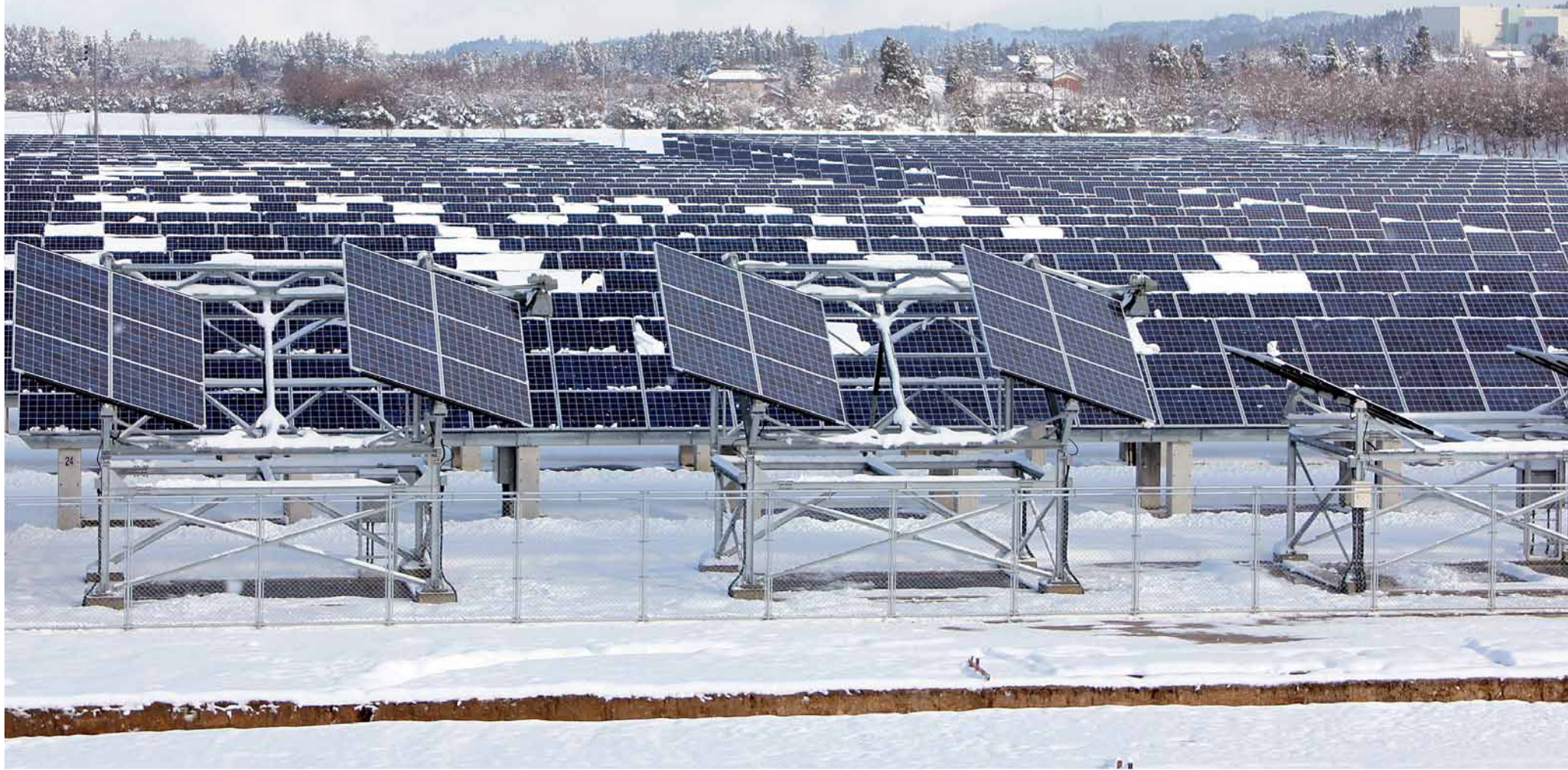
新潟県東部産業団地に大規模太陽光発電所が建設され、10月末から営業運転を開始しています。約3.2ヘクタールの敷地には4,822枚もの太陽光パネルが設置され、年間に、一般家庭300世帯分の電力(1000キロワット＝1メガワット)をまかなうことができるとのことです。(平成23年12月17日撮影)
