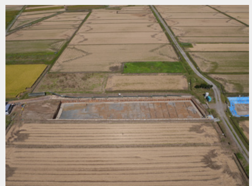
A区 (南から)
