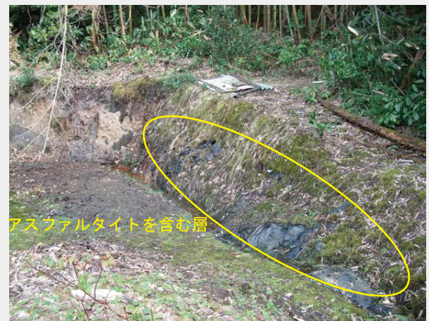
第6図 鎌倉新田付近の土層断面
