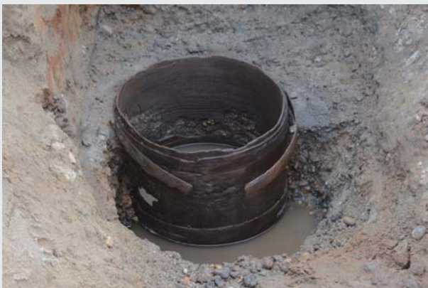
写真2 井戸底に設置された曲物
