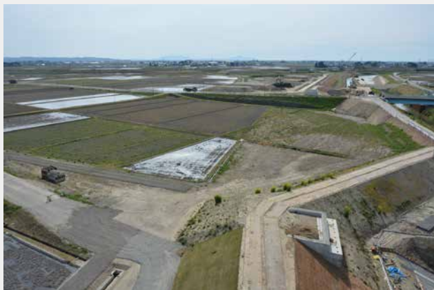
第2図 A区調査前現況（東から）
